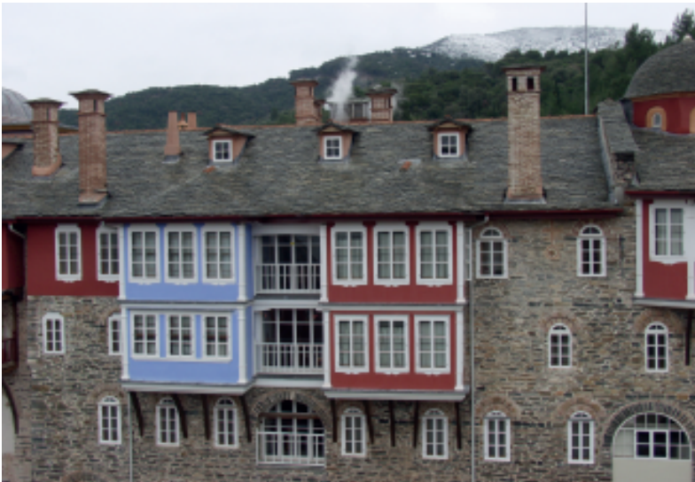
Ἡ Ἀνατολικὴ Πτέρυγα μετὰ τὴν ἀνακαίνιση.
